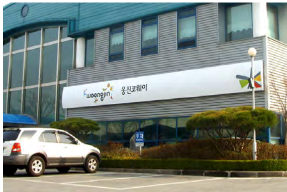
2008' 웅진코웨이, 웅진쿠첸, 웅진식품 공장 사인 디자인, 실시설계 제작, 시공
