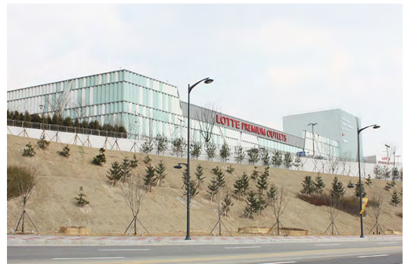
2013' (주)롯데백화점 롯데프리미엄아울렛 이천점 사인 실시설계 제작, 시공
