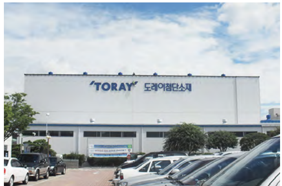
2010~2016' 도레이첨단소재 군산 & 구미공장 사인 실시설계, 제작, 시공
