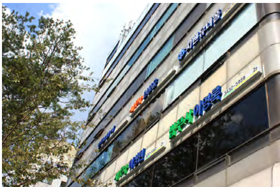
2009' 송파구청 '간판이 아름다운 거리' 정비사업 사인 공사
