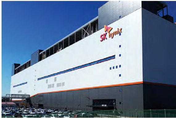
2018' (주)SK 하이닉스 청주 M15 공장 사인물 공사
