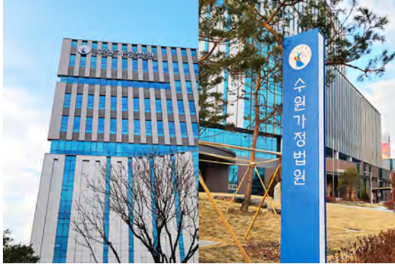
2020' 수원가정법원 사인물 공사 기획 및 디자인, 설계, 제작, 시공
