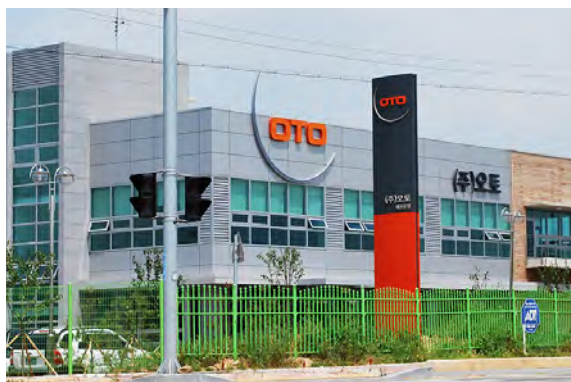
2008' (주)오토 예산공장, 경주공장, 본사 사인 기획 및 디자인, 실시설계, 제작, 시공
